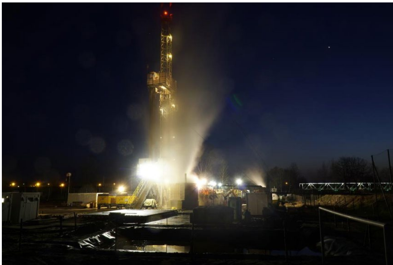
Wiercenie odwiertu geotermalnego w Koninie (woj. wielkopolskie), 2018
